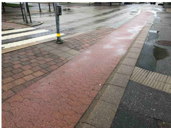
Bild 26. Rullstolar, barnvagnar och cyklister ska kompromissa om utrymme. Nivåskillnad upp mot trottoar.
