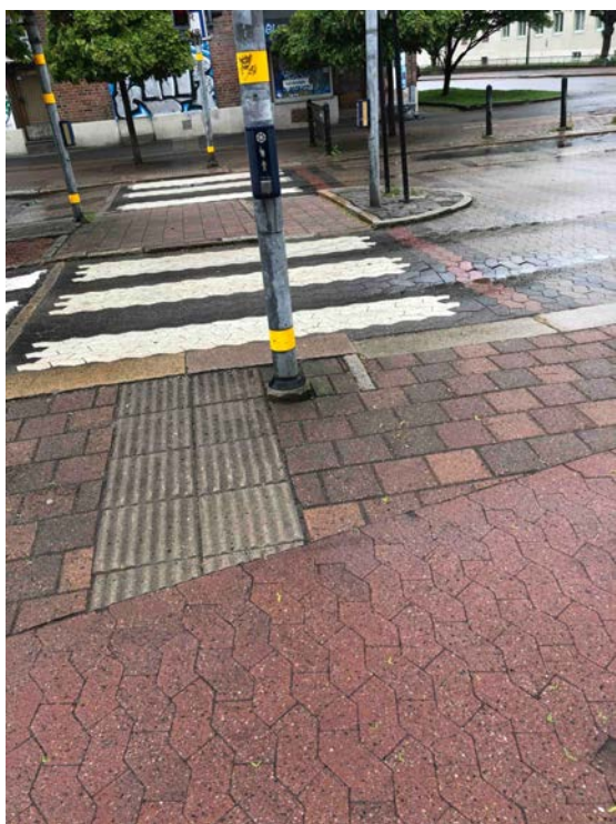
Bild 24. Räfflade ytor för personer med synnedsättningar som innebär ett hinder för rullstolar. Den högra sidan är avfasad kant för rullstol. Foto: Jörgen Lundälv
