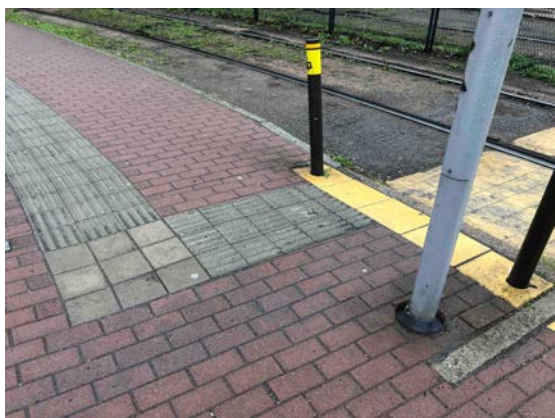
Bild 25. Räfflad yta och gulmarkering för personer med synnedsättning. Foto: Jörgen Lundälv
