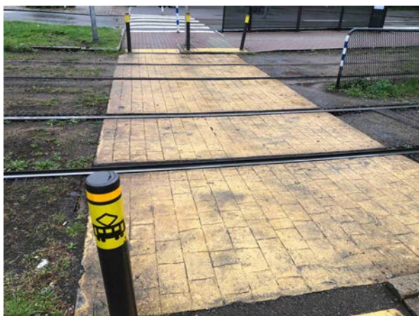
Bild 23. Markeringar för personer med synnedsättningar och spårhinder för rullstolar. Foto: Jörgen Lundälv
